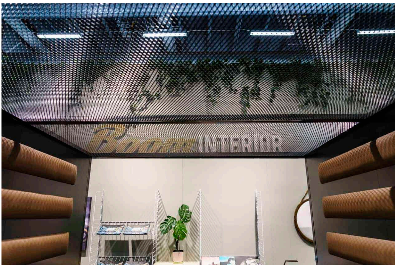
Insidan är täckt med stilrena absorbenter och akustiskt innertak.
