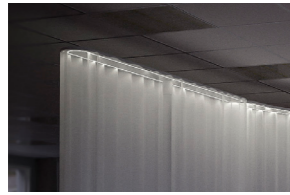
Infälld LED-belysning monterad i toppskiva.
